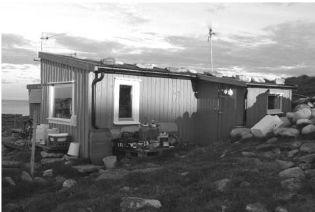
Soloppgang på Hernyken. Stasjonen sett fra øst 10. august 2003 kl. 04:02. Årets tekniske utbedringer var takrenner, ny vindmølle og nytt solcellepanel, som markerte et generasjonsskifte for forsyningen av strøm og vaskevann. Med to retningsbestemte GSM-antenner på taket har vi også en helt annen kontakt med omverdenen enn før. (Foto © T. Anker-Nilssen)
